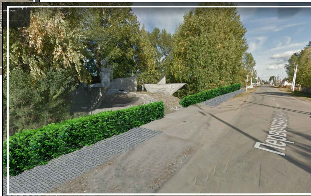
Вид 2 после проведения работ
